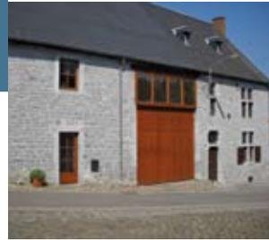
Au centre, un ancien passage de **grange**, récemment aménagé, est surmonté d'une **ouverture horizontale** assurant la transition vers la toiture d'ardoises. A gauche, la trace d'une ancienne **baie en plein cintre** du milieu du 18<sup>e</sup> siècle se lit dans les moellons situés au-dessus de la porte. Desservie par une porte à *linteau* bombé à clé, une **étable** sous fenil de la fin du 18<sup>e</sup> siècle vient clore l'ensemble.
